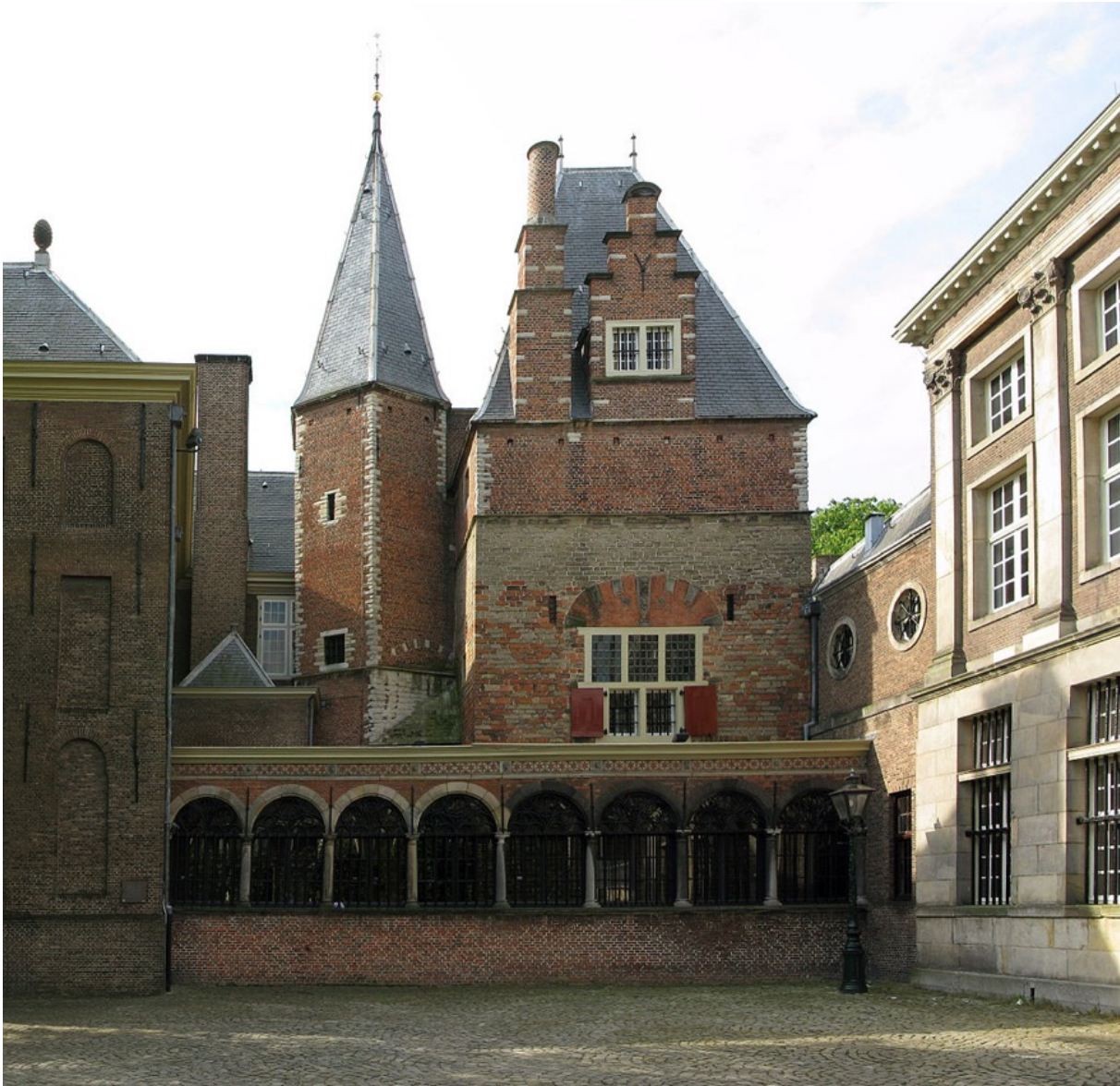
Gravensteen, on the Gerechtplein, Leiden
