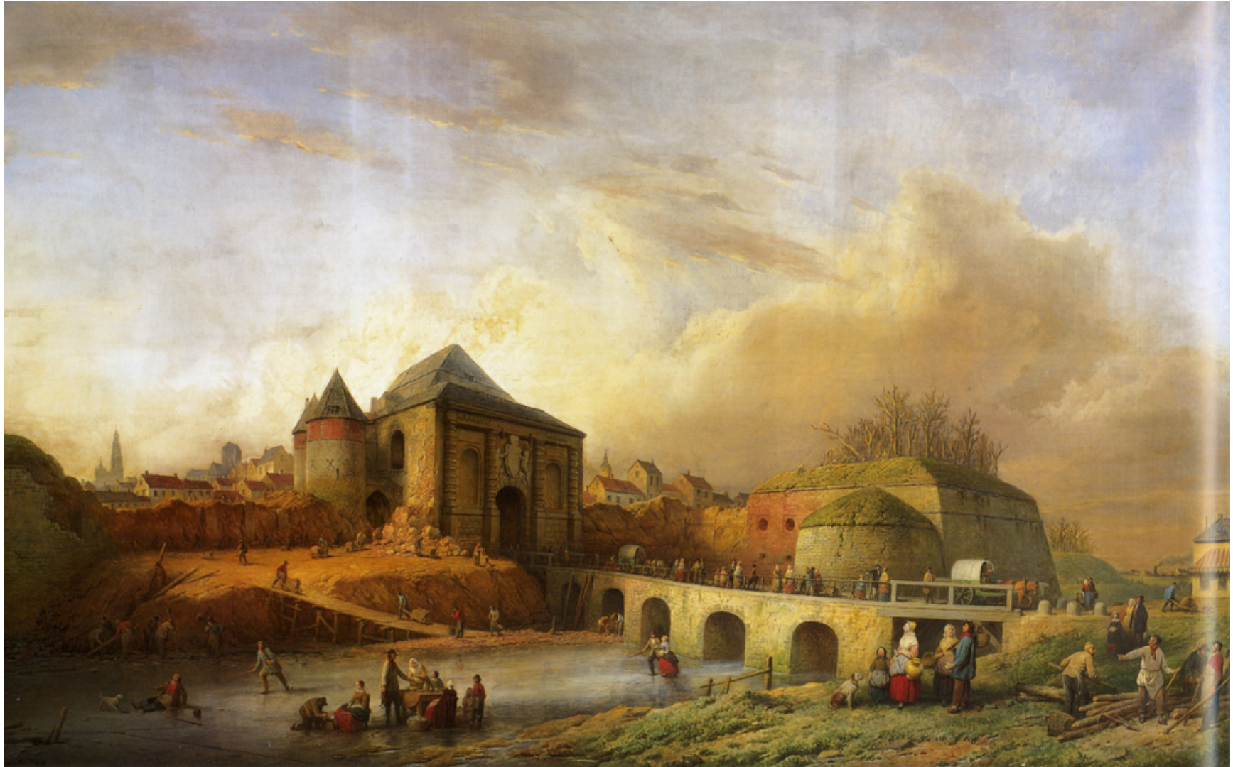
The Demolition of the Kipdorppoort (one of the entrance gates) of Antwerp, Fedinand de Braeckeleer, 1876, Museum Vleeshuis, in Rutger Tijs, Antwerpen: Atlas van een Stad in Ontwikkeling (2007), p. 138.
